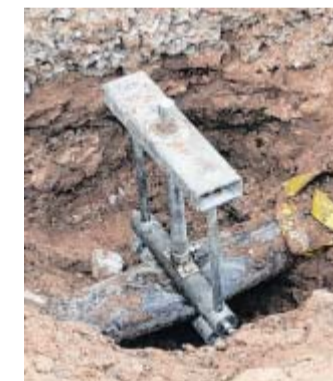
Abgeklemmte Leitung: Dafür musste tief gegraben werden.
